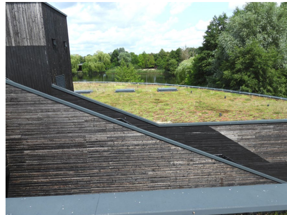
Abb. 2: Ein Teil der unteren Ebene des begrünten Daches mit Blick auf die hölzerne Gebäudefassade im Juni 2023.
